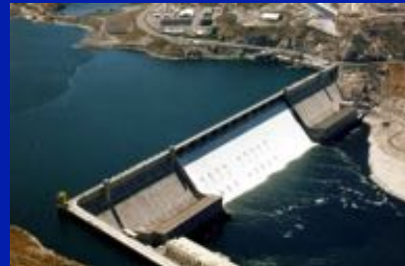
Grand Coulee, WA 6809 MW
